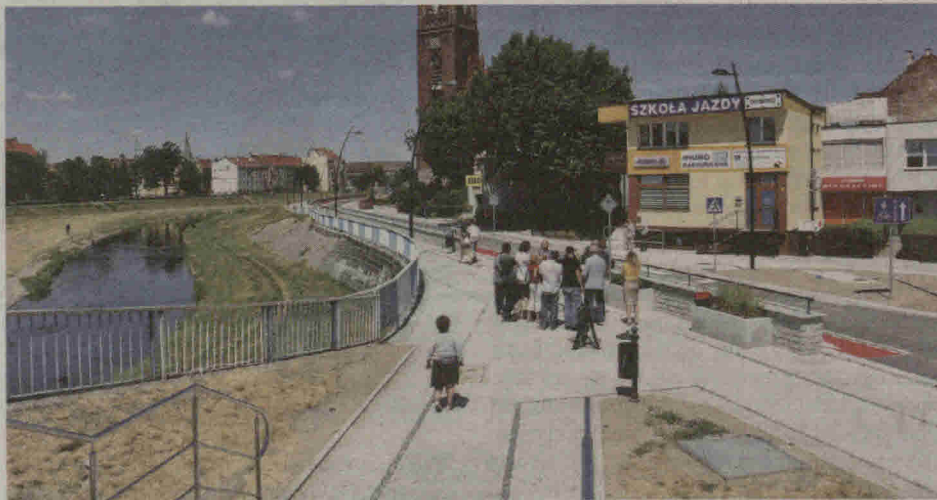
Bulwar nad Kaczawą został wybudowany w ramach rewitalizacji legnickiej dzielnicy Kartuzy
