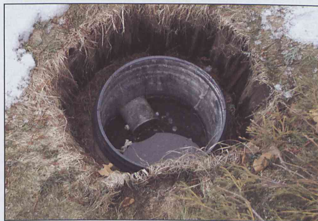
Fot: D. Szypuła. Jednokomorowy osadnik gnilny (widok z góry, osadnik usytuowany w gruncie).
