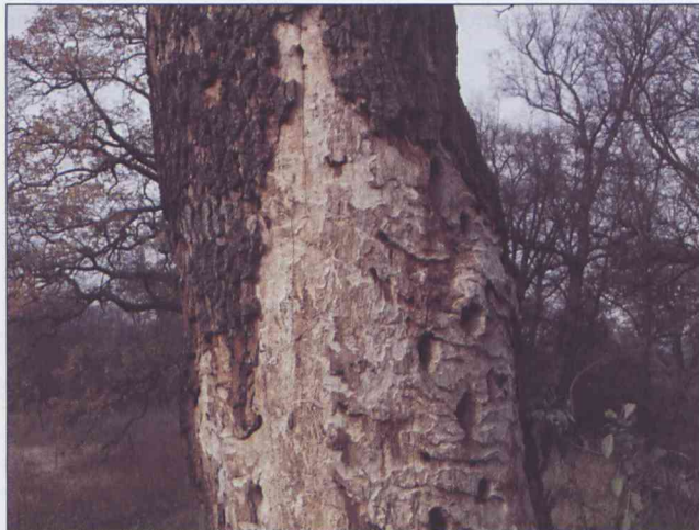
Fot: R. Kuźmiński. Obraz uszkodzeń.
