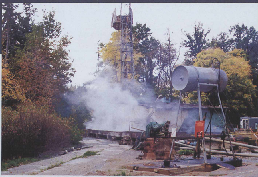
Ryc. 1. Aparat wiertniczy nad otworem "C-1" po nawierceniu wody termalnej (fot. M.W. Lorenc)
