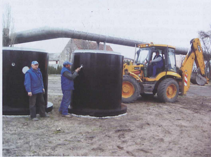
Ryc.2 W podwrocławskich Radwanicach i Siechnicach powstaje ponad 6,3 km sieci kanalizacyjnej. (Fot. Gmina Św. Katarzyna)
