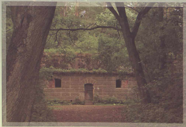
Schron małego fortu piechoty
