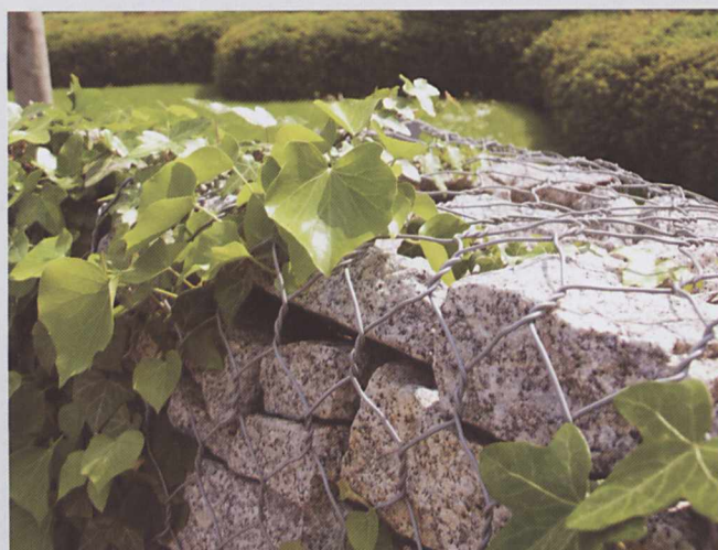
Widoczny podwójny splot siatki gabionu
