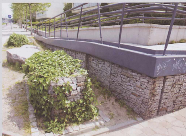
Gabionowa podbudowa podjazdu dla niepełnosprawnych
