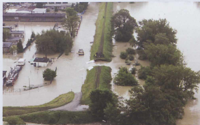
Przerwane wały przeciwpowodziowe
