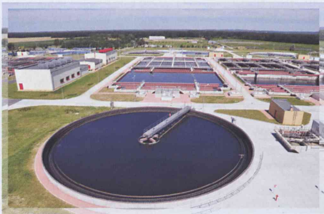
ciąg biologiczny WOŚ. Na pierwszym planie jeden z pięciu osadników wtórnych
