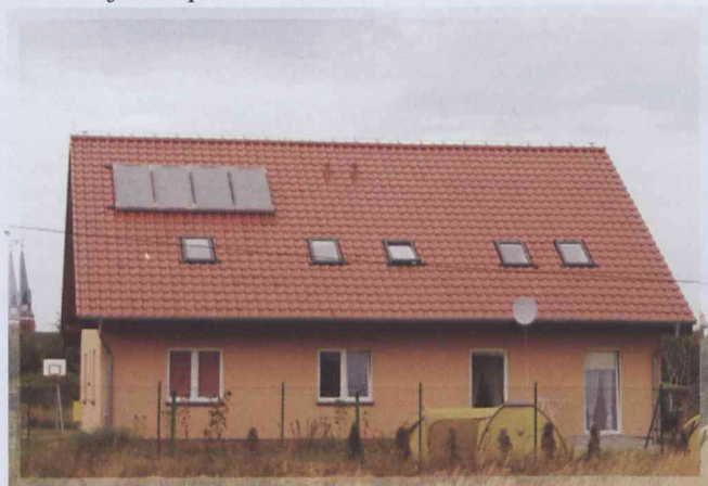
Solary termiczne na budynku Domu Dziecka w Żarach
