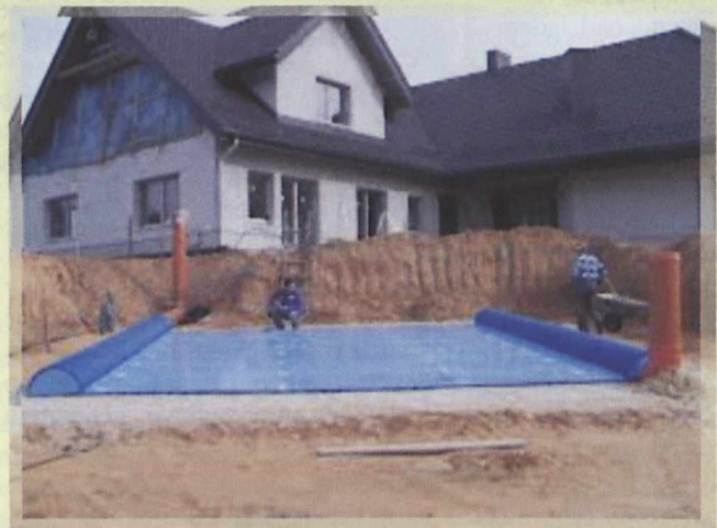
Montaż bezprzeponowego gruntowego wymiennika ciepła (płyty)
