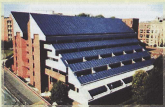
Ogniwa fotowoltaiczne na budynku Uniwersytetu Georgetown w Waszyngtonie
