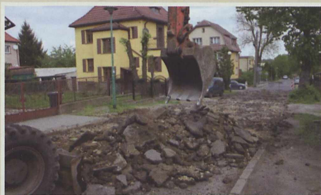
Budowa nowej kanalizacji
