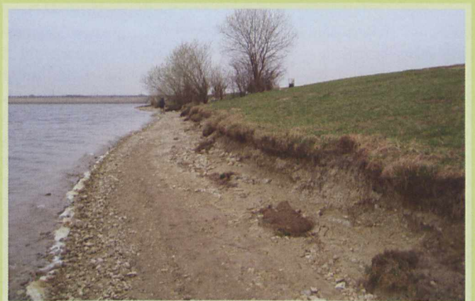
Niszczony abrazją brzeg zbiornika
