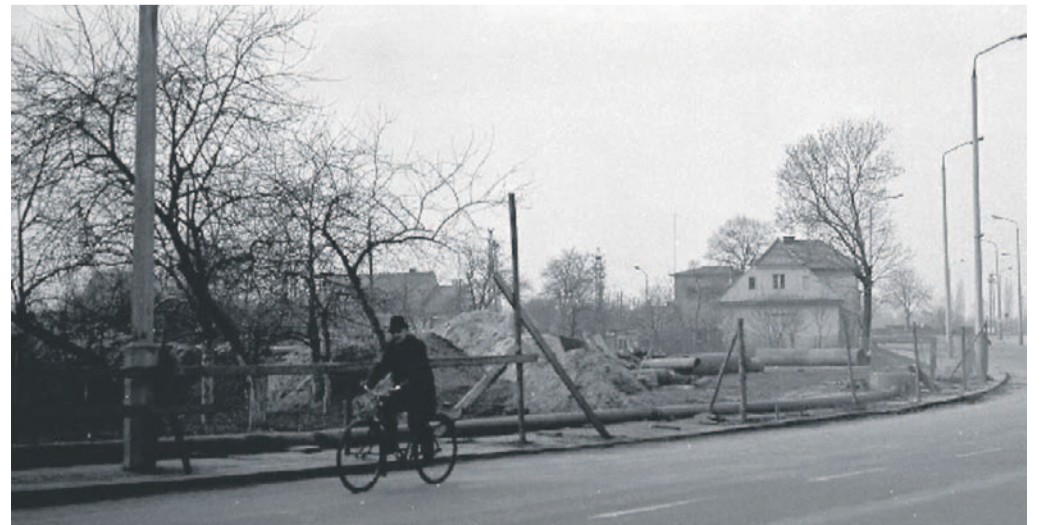
Ul. ks. Fr. Kutrowskiego - w głębi ul. Nowosadnicza, po lewej (tego nie widać) w ogrodach zbudowano przepompownię ścieków
