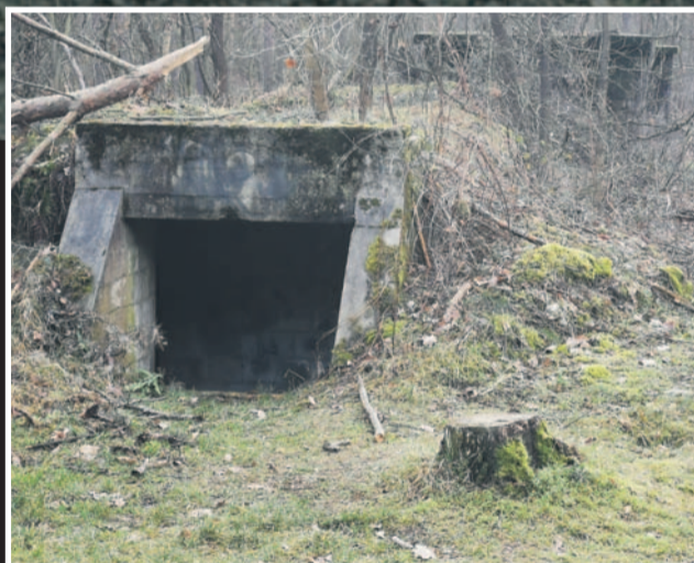
Od strony południowej do miejsca, gdzie stały baraki przylegają cztery identyczne kilkudziesięciometrowe podłużne schrony - każdy z trzema wyjściami
