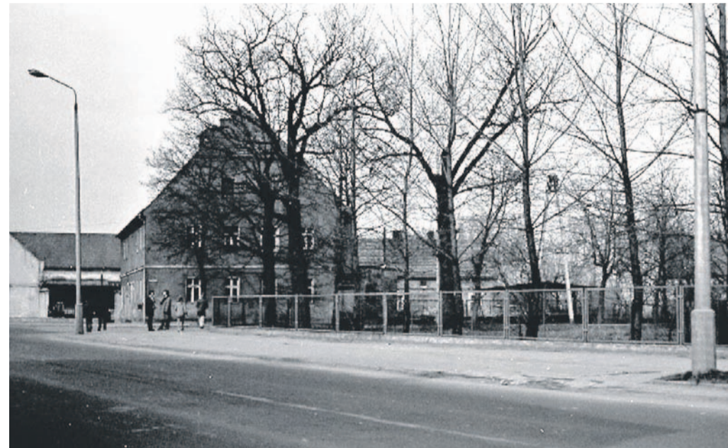
Skrzyżowanie ul. ks. F. Kutrowskiego z Lipową - na wprost dawny budynek biurowy Zakładu Usługowego Remontowo-Budowlany WZGS z Wrocławia. Dziś stoi pusty
