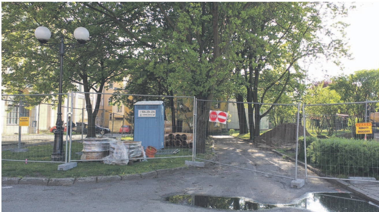
Rozpoczęła się przebudowa nawierzchni Placu Piastów w Oławie
