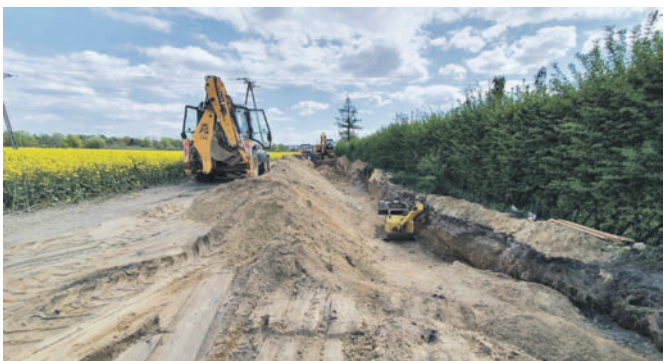
Budowa kanalizacji deszczowej
