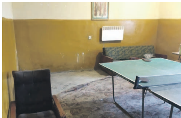
Tak wyglądało pomieszczenie w świetlicy przed remontem
