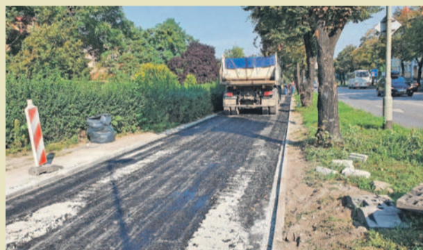
Trwają prace przy przebudowie ciągów pieszo-rowerowych wzdłuż ul. 3 Maja (na odcinku od skrzyżowania z ul. B. Chrobrego do skrzyżowania z drogą krajową nr 94 - ul. Andersa). W ubiegłym tygodniu układano masę bitumiczną
