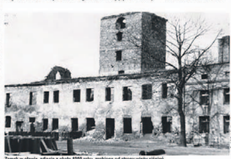
Zamek w Oławie, widok z około 1950 roku, rozbudowany od strony wschodniej
