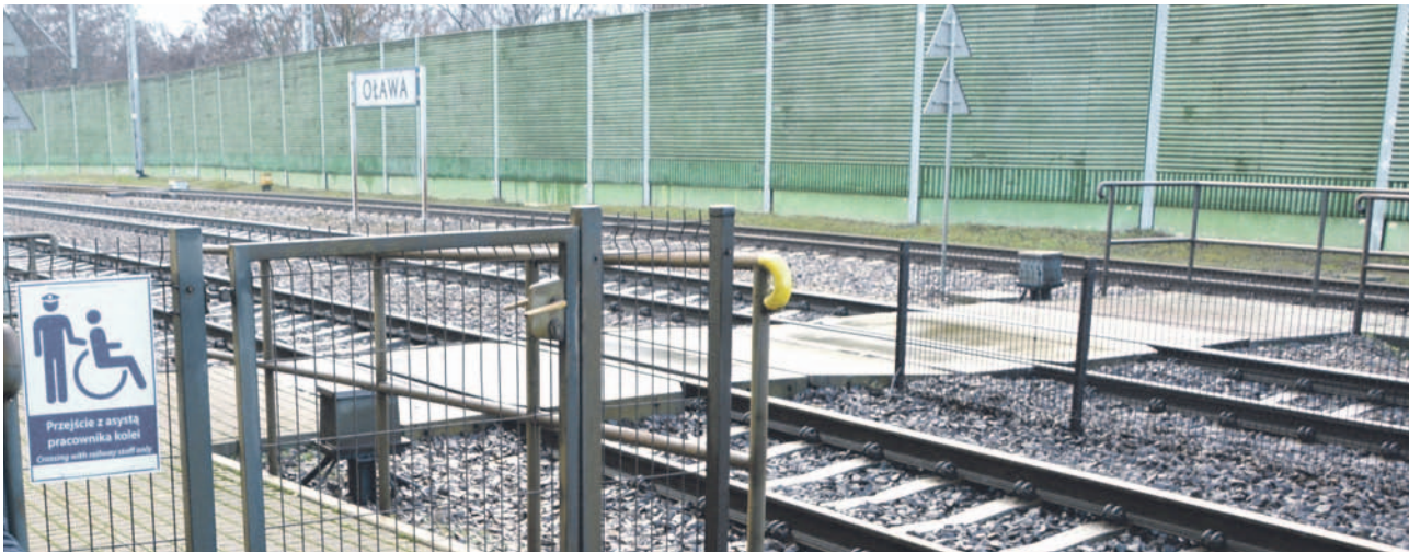
Przejście dla niepełnosprawnych jest, ale klucza od ręki nie ma...
