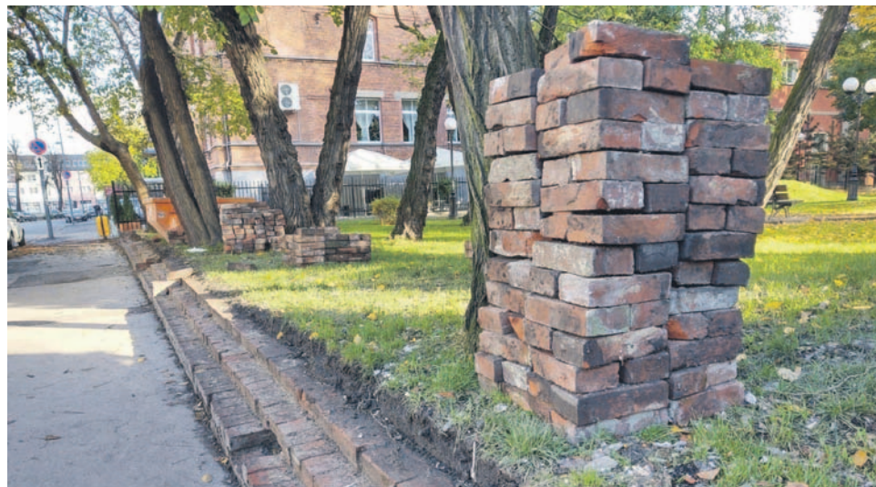
Murek będzie odtworzony z tej samej cegły
