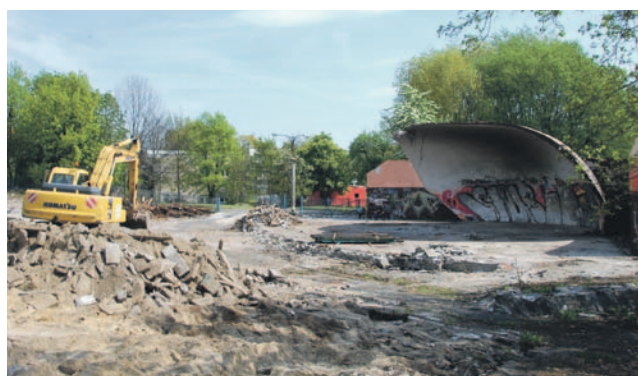
W kwietniu 2010 roku oławski amfiteatr wyburzono. Burmistrz nie planuje budowy nowego
