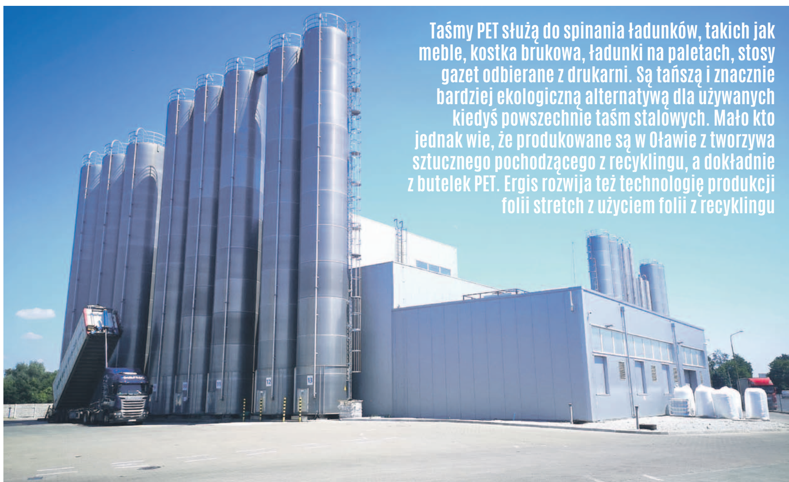
Charakterystyczne silosy oławskiego oddziału Ergis S.A.
