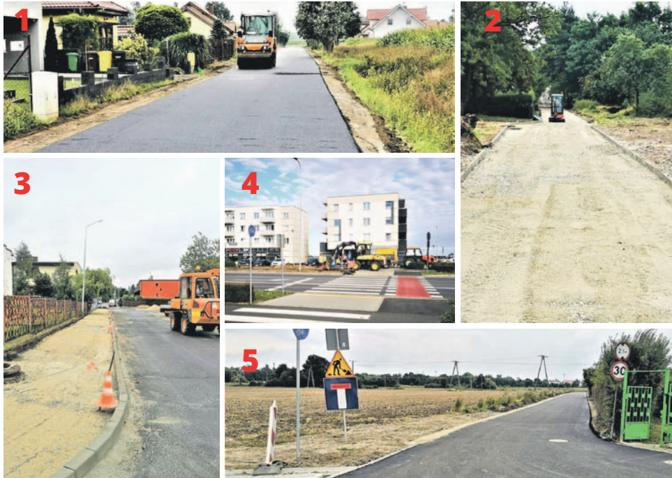
1. Nakładka bitumiczna na ul. Krasińskiego 2. Ścieżka pieszo-rowerowa przy ul. Opolskiej 3. Chodnik przy ul. Wrzosowej 4. Druga zatoka przy skrzyżowaniu ulic Iwaskiewicza - Łagodna 5. Fragment „Drogi Ulgi” od ul. Kilińskiego do mostu na rzece Olawie (wzdłuż ogrodów działkowych)
