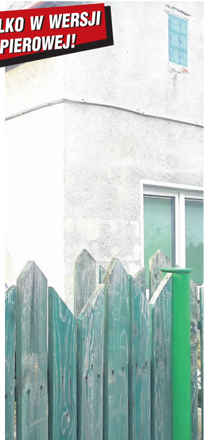
Gdy pan Zbyszek wieczorem wrócił do domu, zjadł kolację i kładł się spać, nic niepokojącego na piętrze nie zauważył
