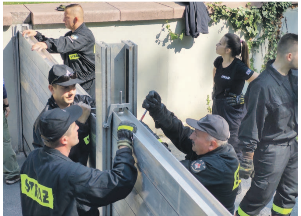
Między innymi od właściwego zamocowania belek zależy szczelność szandorów
