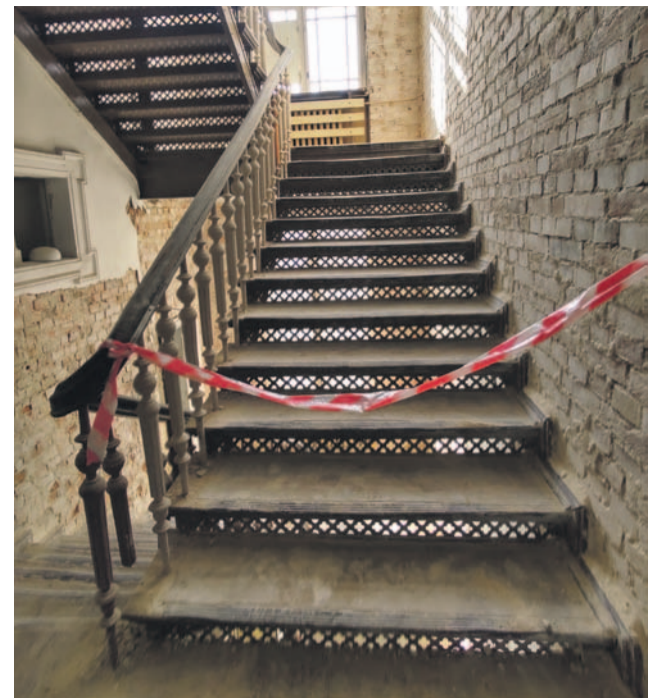
W zabytkowym obiekcie jest wiele elementów, które zostaną zachowane, w tym schody
