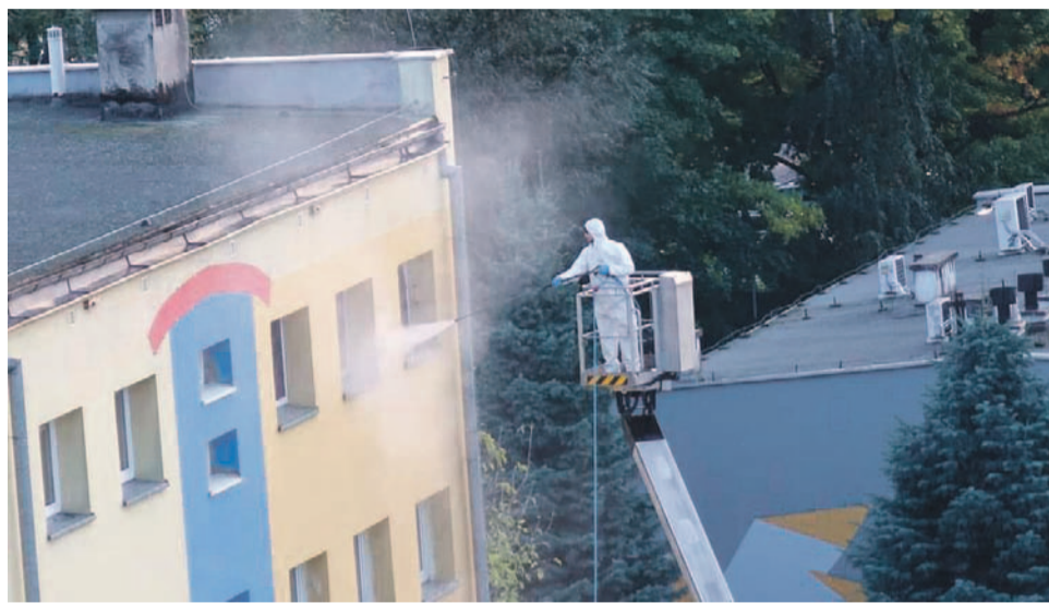
Pracownicy podczas czyszczenia byli zabezpieczeni w kombinezony
