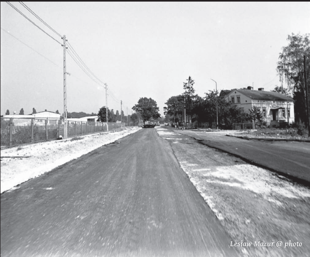
Ulica Zwierzyniecka w trakcie przebudowy - zdjęcie z 1971 roku, po prawej wjazd na cmentarz
