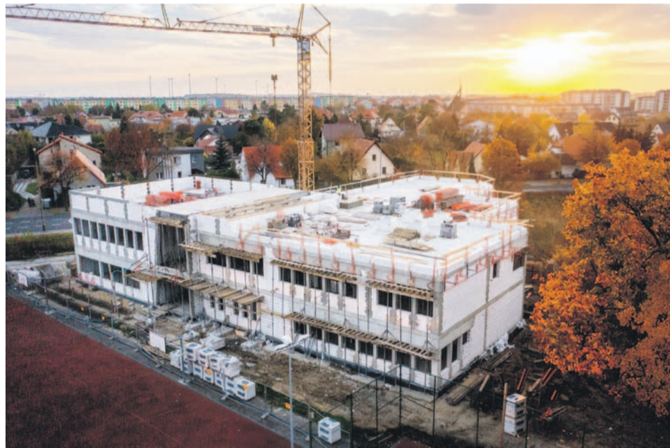
Plac budowy profesjonalnych warsztatów szkolnych
