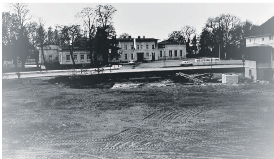
1973 - dworzec kolejowy PKP, plac przebudowany w związku z budową wiaduktu
