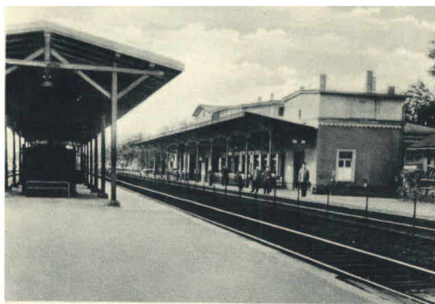
Ohlau i. Schles., Bahnhof
