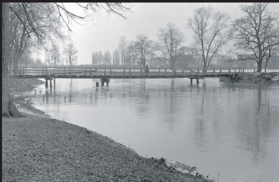
Drewnianej kładka łącząca Strzelną z pl. Zamkowym - zdjęcie zrobiłem w 1960 roku. Dziś w tym miejscu stoi betonowy most
