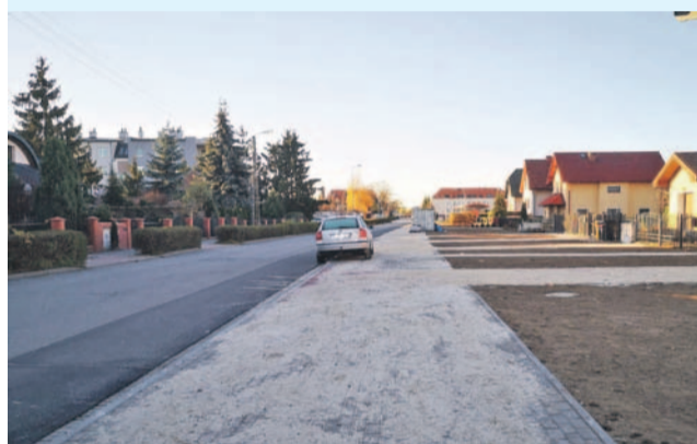
Chodnik oraz kanalizacja deszczowa na ul. Nowoosadniczej
