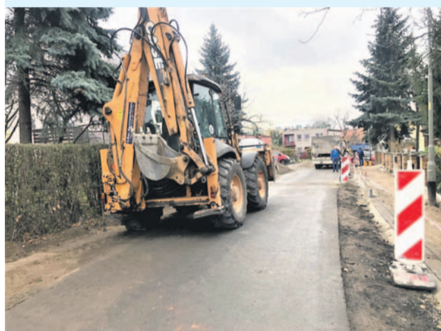
Kanalizacja deszczowa oraz chodnik na ulicy Okólnej
