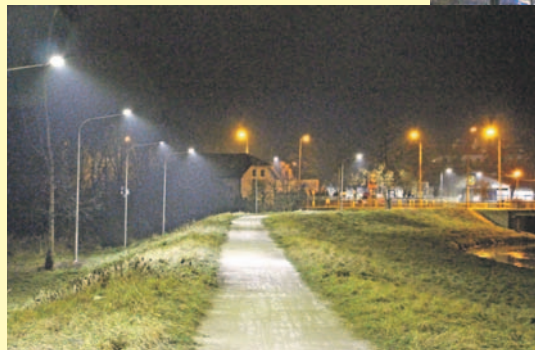
Nowe oświetlenie chodnika od Placu Zamkowego do ul. 3 Maja (wzdłuż ogrodzenia Starostwa Powiatowego)
