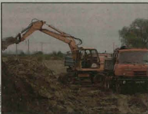
Na tym gruzowisku powstanie pełnowymiarowa sala gimnastyczna
