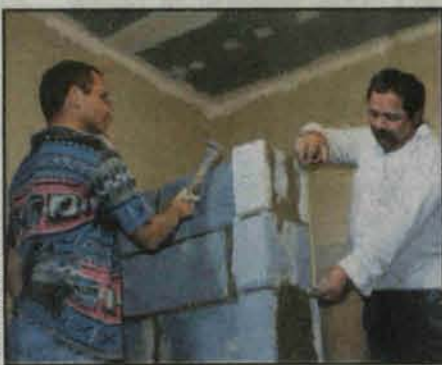
Podczas prac remontowych
