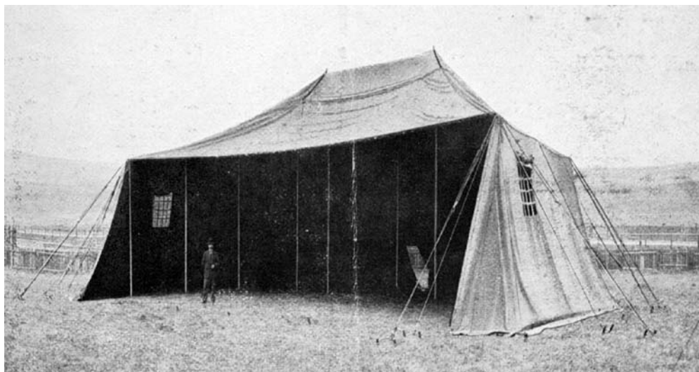
Fot. 7. Namiot-hangar do przechowywania samolotów. Zdjęcie z – APJG, AmJG, sygn. 8829, (Fluglandenplatz)
