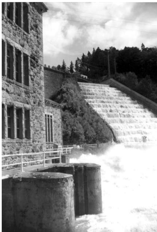
Do przelania zapory w Pilchowicach brakowało 40 cm, fot. M. Junik
