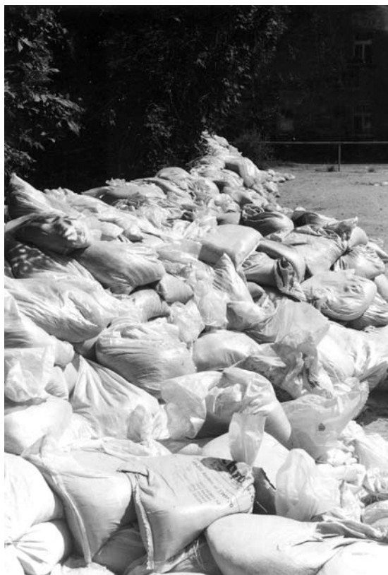
Wał przeciwpowodziowy, usypany z worków z piaskiem, fot. M. Junik
