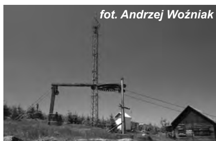
Zniszczone zabudowania górnego odcinka dawnego wyciągu „Świeradowiec”
