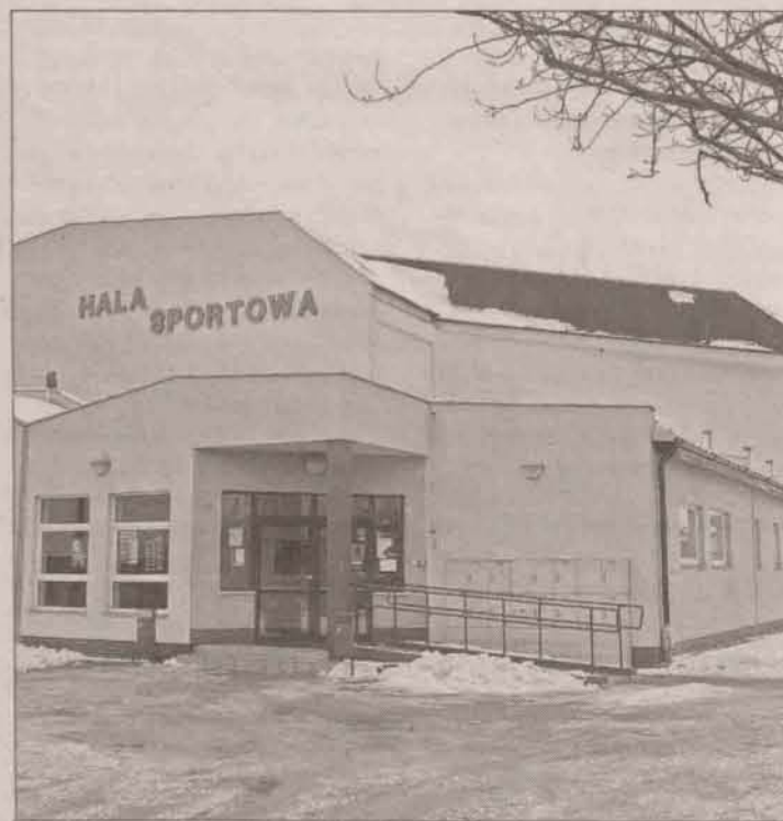
Dach hali sportowej przy SP 2 został dokładnie sprawdzony
