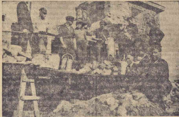
Odbudowa zburzonej nastawni.
