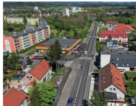
Przebudowa ulicy Ogińskiego: 6,3 mln zł.
