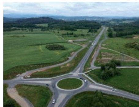
Obwodnica południowa Jeleniej Góry: 55,9 mln zł
