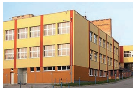
Przebudowa budynku i terenu Szkoły Podstawowej nr 11 w Jeleniej Górze: 2,7 mln zł
