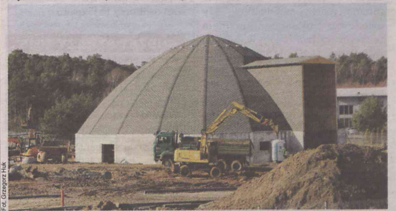
Z daleka widoczny jest charakterystyczny magazyn soli drogowej
