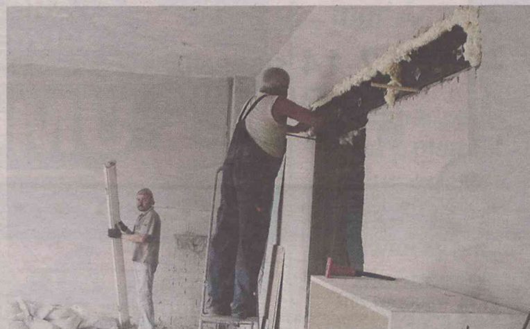
Jeśli to wakacje, to w szkole trwają remonty
