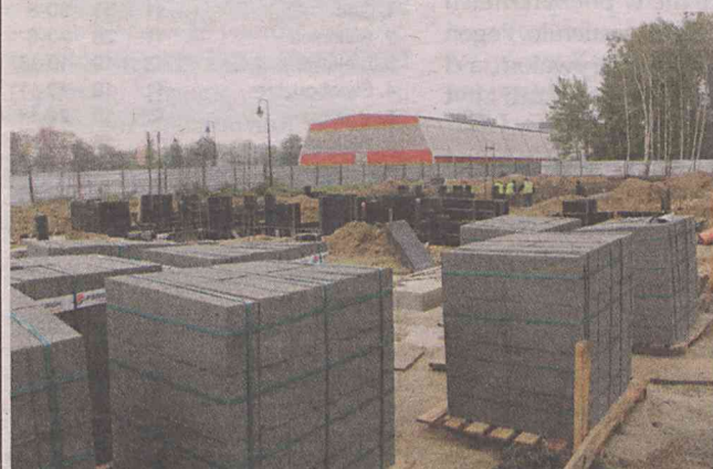
Budowa przedszkola idzie pełną parą
