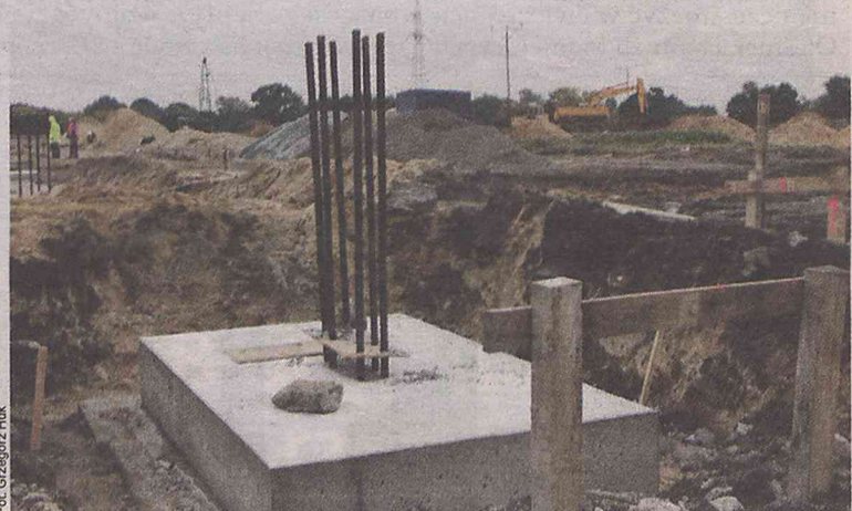
Tak powstaje konstrukcja hali
