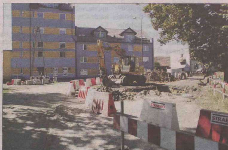
Przy Biersinie przebudowano kanalizację deszczową
