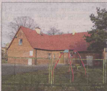
Świetlica w Jemielnej ma nowy dach
