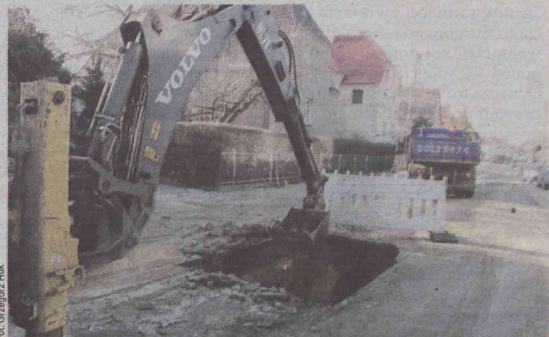
Konieczne było uszczelnienie magistrali wodociągowej
