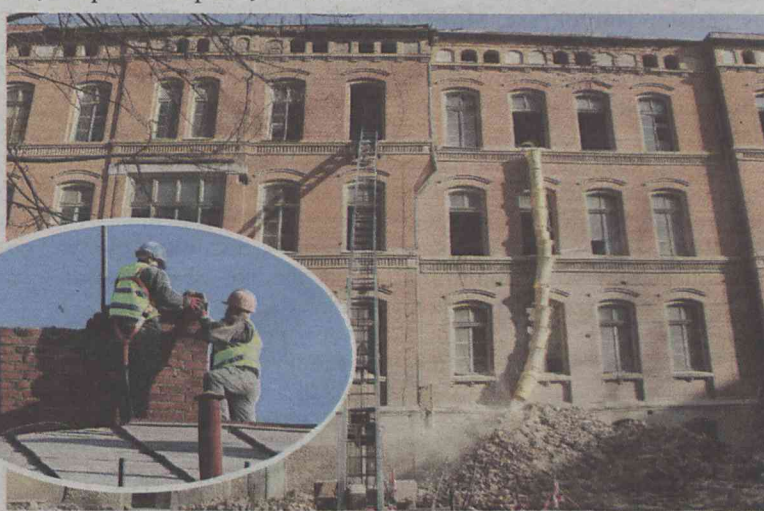
Prace remontowe postępują w dobrym tempie
