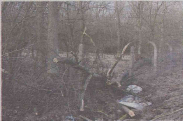
Uszkodzone ogrodzenie lotniska na Spalicach
