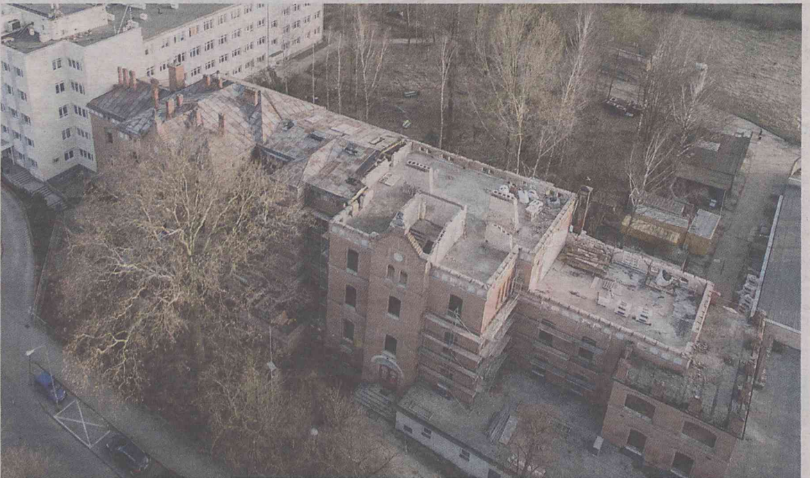
Konstrukcja dachu została rozebrana
