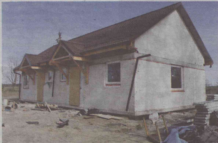
W Krzeczynie powstaną dwa budynki mieszkalne
