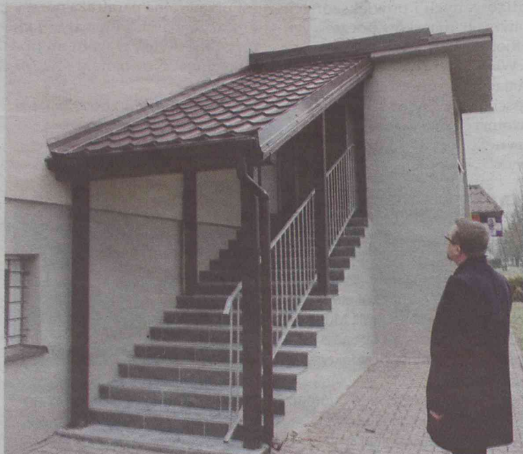
Wójt Marcin Kasina dogląda prac remontowych w świetlicy w Boguszykach Osiedlu
