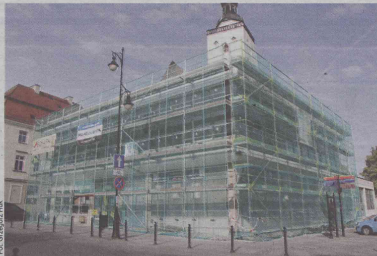
Remont nabrał tempa
