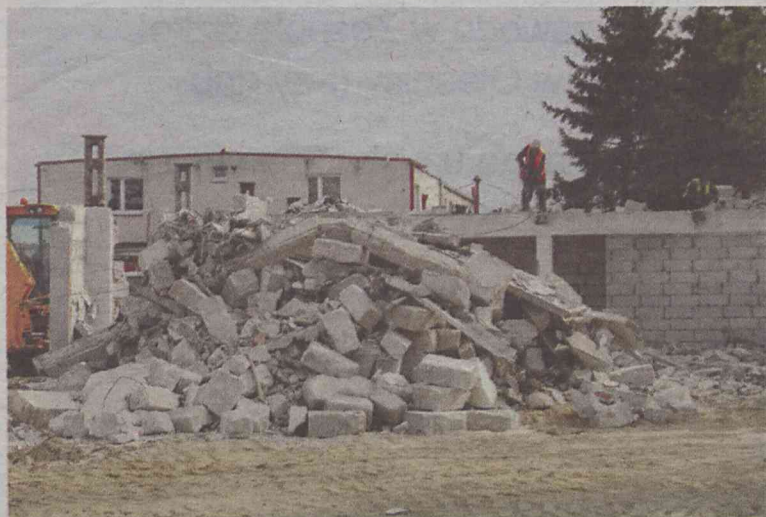
Trwa wyburzanie starego magazynu
