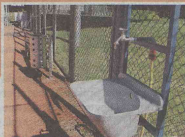
Zamontowano właśnie umywalki
