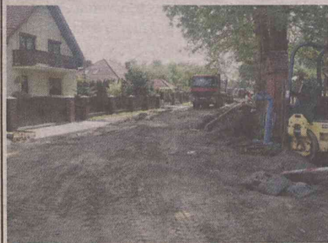
Topolowa w trakcie prac budowlanych...
