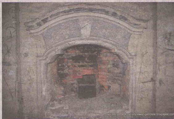
Na piętrze znajdował się kominek – na ceglach widać jeszcze ślady sadzy
