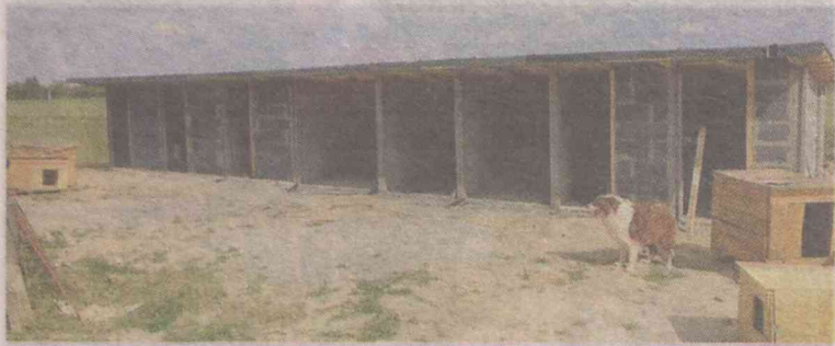
Nowy obiekt powstał szybko
