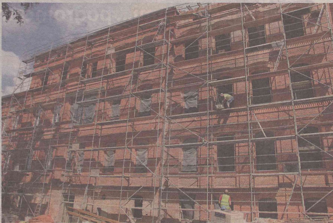
Prace postępują w szybkim tempie
