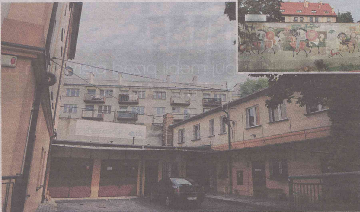
Inwestor chce podwyższyć budynek po prawej stronie - ten z murem (patrz - zdjęcie wyżej)
